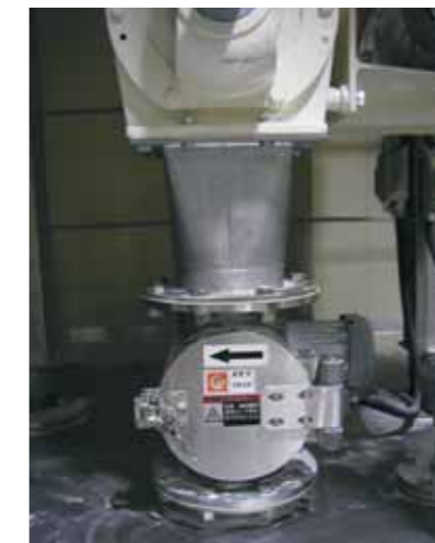
MGPH-RVDH 高磁力ロータリー式二重管タイプ
